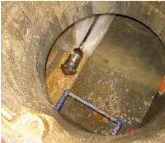
Abbildung 15: Rotationsspüldüse im Steinhaustunnel [20]
