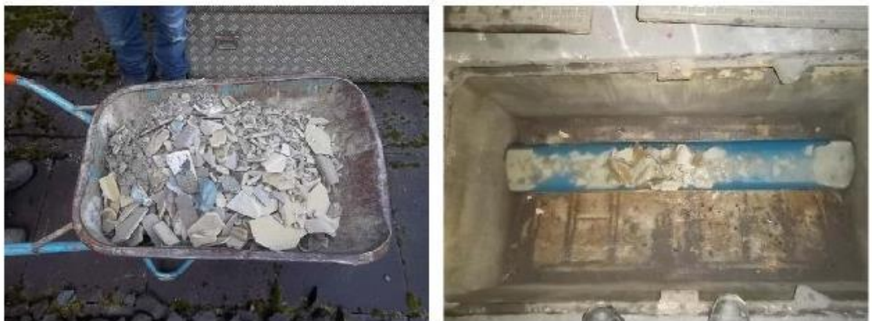
Abbildung 16: Zeugnis harter Ablagerungen von Sinter im Zammer Tunnel [23].
