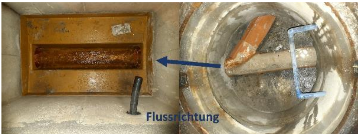
Abbildung 18: links: Revisionsnische (RN 05 E) vor der Reinigung; rechts: Mischwasserbildung, Drainagen vor der Reinigung mit und ohne Versinterungen. Der blaue Pfeil signalisiert die Flussrichtung.
