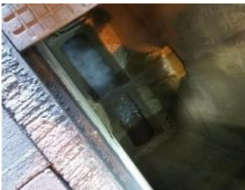
Abbildung 14: Einleitung der Ulmendrainage in die Sohl drainage mit Fallstrecke des Wassers [16].
