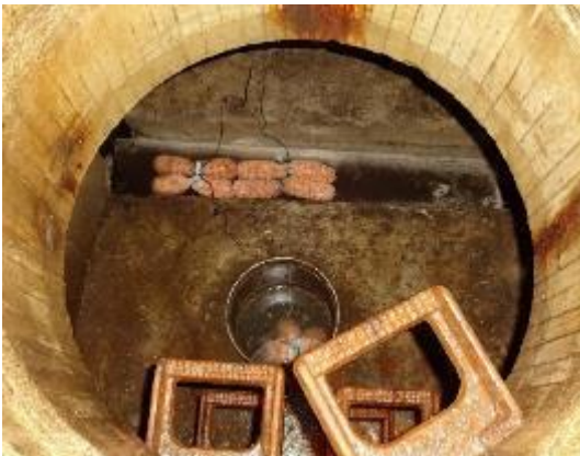
Abbildung 23: Nachbestückte Härtestabilisatoren, 8x500g in Transportleitung, 6x500g im Überlaufbrunnen [24].
