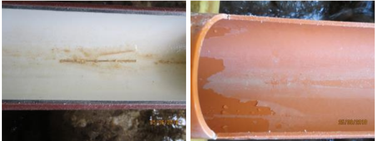
Abbildung 33: Versinterung der Drainageschlitz (a) und Ablagerung von Versinterungsschichten innerhalb der ersten 4 Monate.
