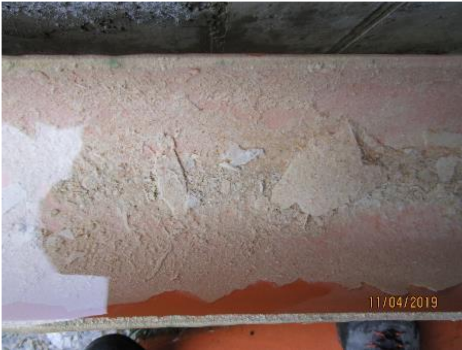
Abbildung 35: Abgeplatzte Sinterkrusten in der Drainage-Teststrecke des Tunnels Steinhaus
